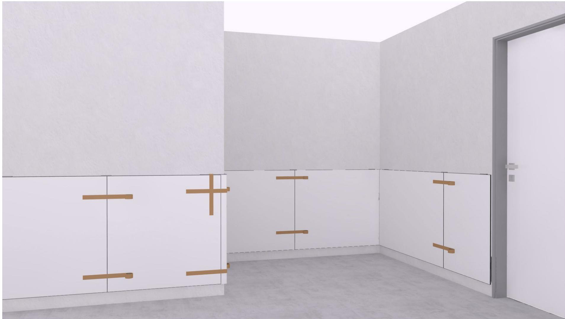
Entfernen Sie die Profilabschnitte die Sie zum Fixieren der Platte benötigt haben.
