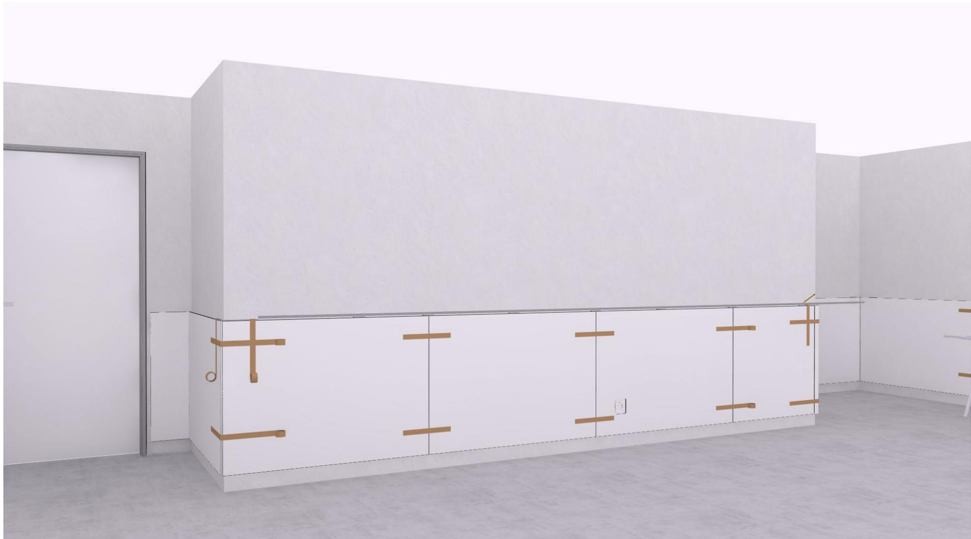
Schneiden Sie die Abdeckprofile mit einer Kappsäge passgenau dazwischen.
