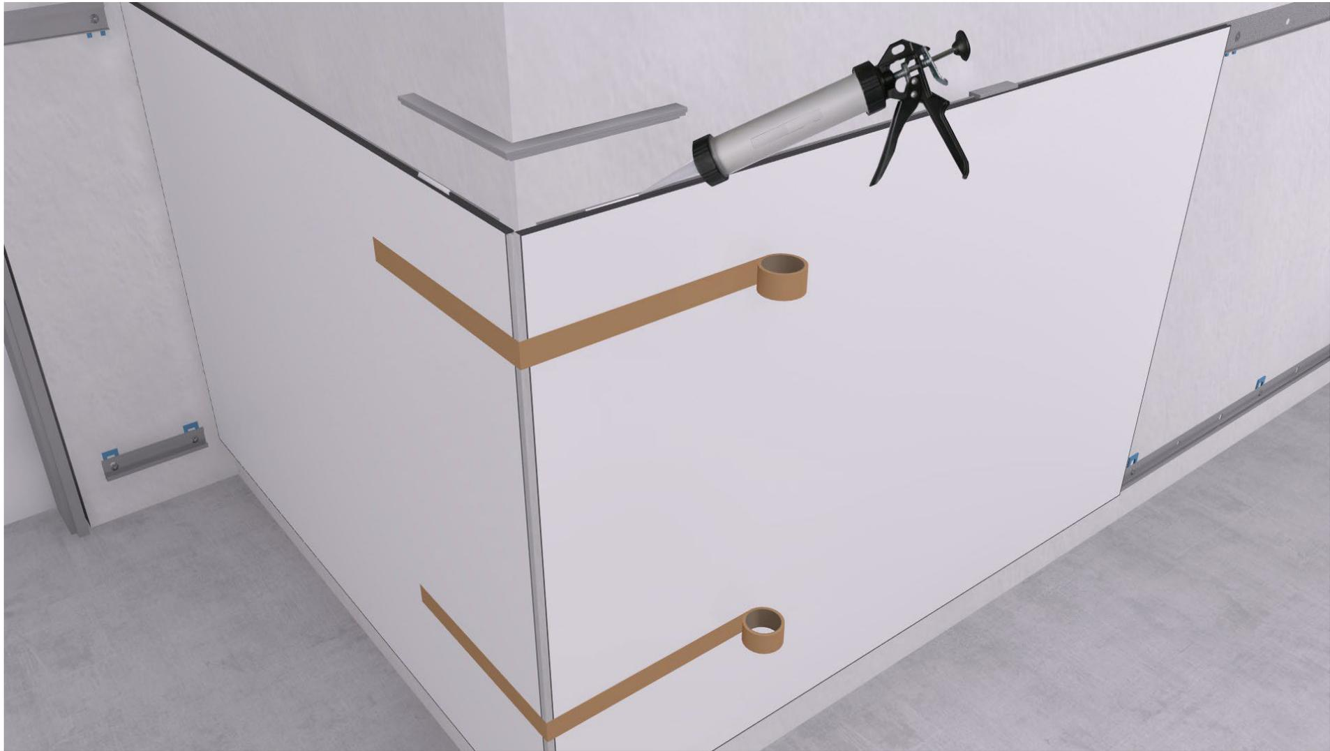
Verkleben Sie die Eckprofile mit dem mitgelieferten Hybridkleber. An der Innenflanke der Nut und zusätzlich punktuell am Eckprofil.
