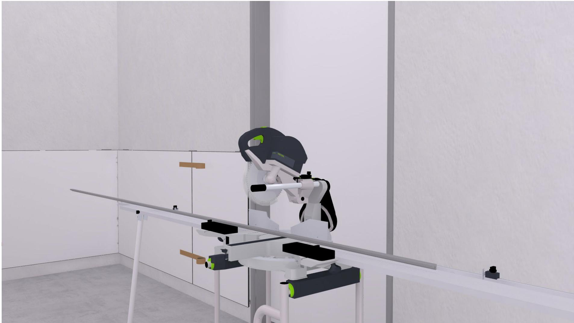
Schneiden Sie die Abdeckprofile mit einer Kappsäge passgenau dazwischen.
