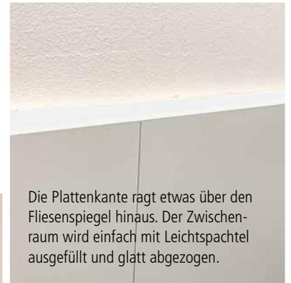
Die Plattenkante ragt etwas über den Fliesenspiegel hinaus. Der Zwischenraum wird einfach mit Leichtspachtel ausgefüllt und glatt abgezogen.
