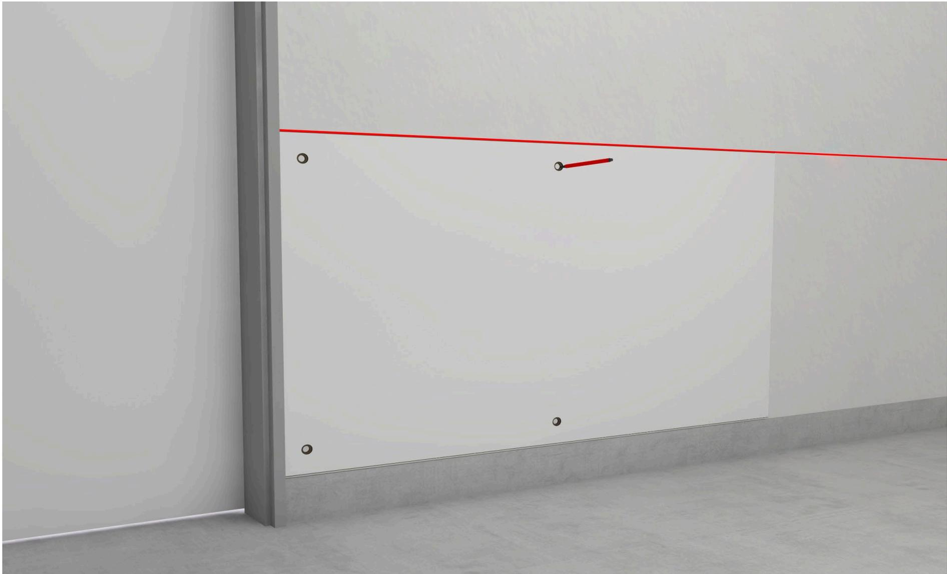
Mittels Laser die Oberkante Wandschutz abbilden und Bohrlöcher an der Wand anzeichnen.
