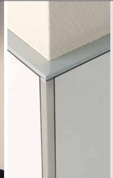
Außeneck aus einem Vierkantprofil aus Edelstahl.
