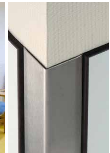
Außeneck mittels aufgeklebtem Edelstahlwinkel Stärke 1,5 mm, 3-fach gekantet
